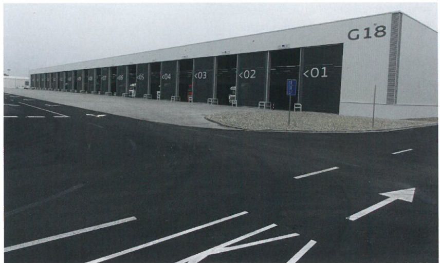
Die von BIT Ingenieure und gevas humberg & partner ermittelte Vorzugsvariante für den südlichen Wareneingang wurde umgesetzt
